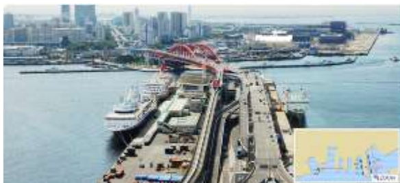
Gambar 5 : Terminal pelabuhan kobe tampak dari udara Sumber : www.kobe-meriken.or.jp , diunduh 16 Juni 2013
