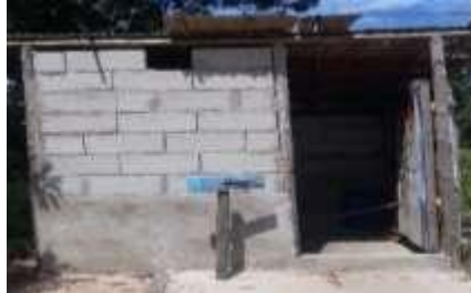
Gambar 6. Kondisi Toilet Atau Ruang Ganti
