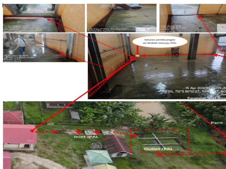
Gambar 4. Alur Aliran Air Limbah menuju IPAL dan Kondisi IPAL Sumber: Foto Hasil Observasi 2023
