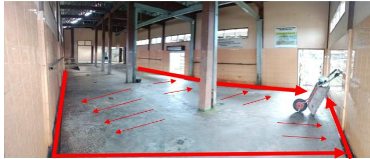
Gambar 3. Proses Aliran Air Limbah Menuju Saluran Pembuangan Sumber: Foto Hasil Observasi 2023
