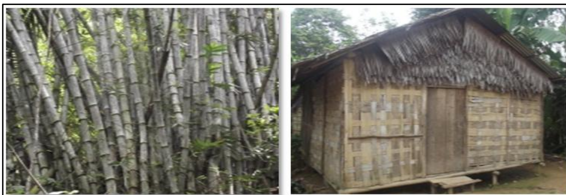
Gambar 1. Bangunan rumah masyarakat Dusun Pandan menggunakan bambu betung dan bambu munti. ( The homes of the Pandan Hamlet community built with Betung bamboo and Munti bamboo )
