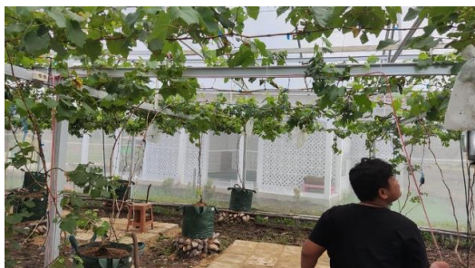
Gambar 10. Pemasangan Terminal Kabel Listrik
