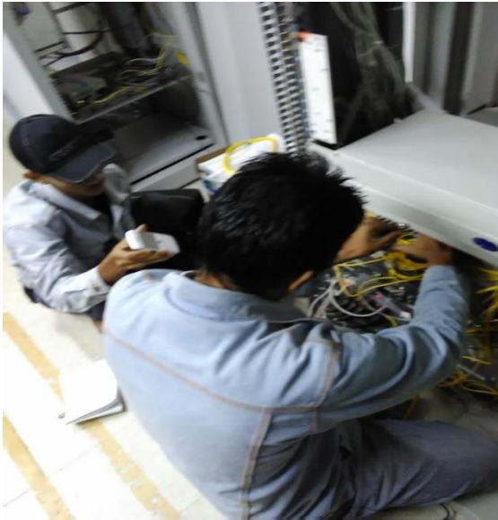
Gambar 2. Optical termination Box (OTB) di STO Tebas sebagai Rx.
