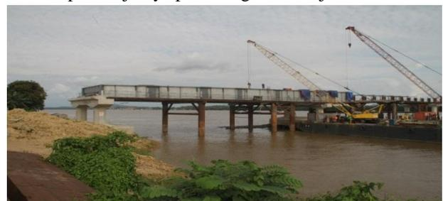
Gambar 8 : Pemasangan Balok Baja Jembatan I Tayan
