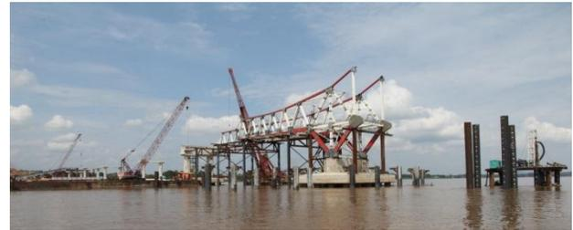
Gambar 11 Pemasangan Erection Pertama Struktur Rangka Baja dan Temporary breahead
