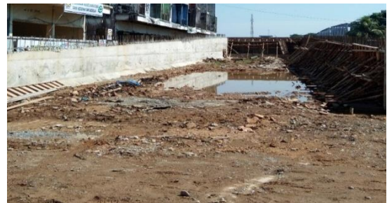
Gambar 3. Oprit Duplikasi Jembatan Landak
