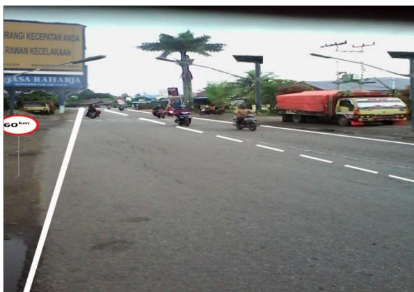
Gambar 10. Kondisi Penanganan Jalan Khatulistiwa Sta4 – Sta5
