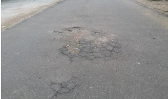
Gambar 7. Retak Blok
