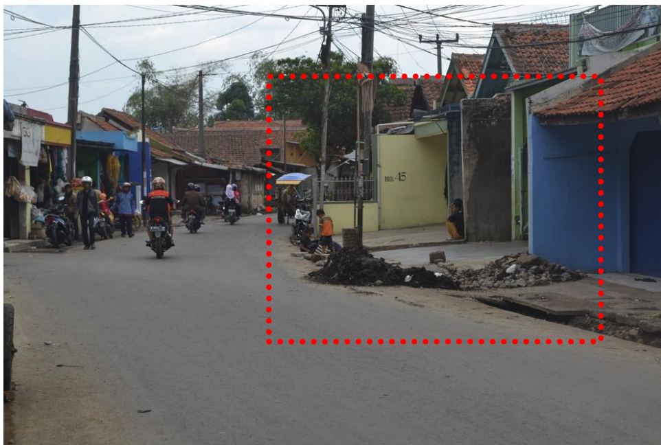
Gambar 5. Perbaikan saluran drainase di jalan Cigondewah. Sumber: Dokumentasi, 2017
