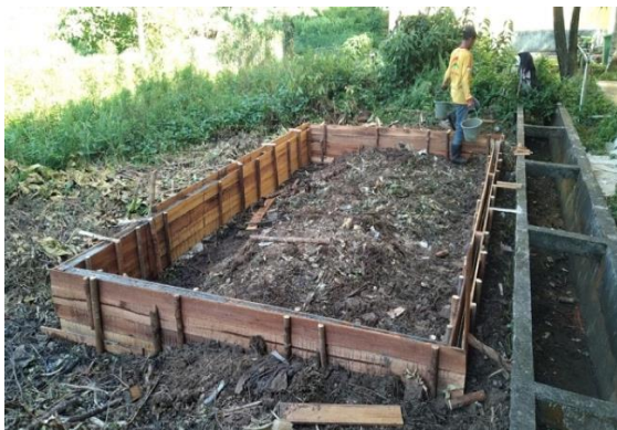
Gambar. 8 Tahap Pengerjaan Awal Pembangunan Smart Greenhouse
