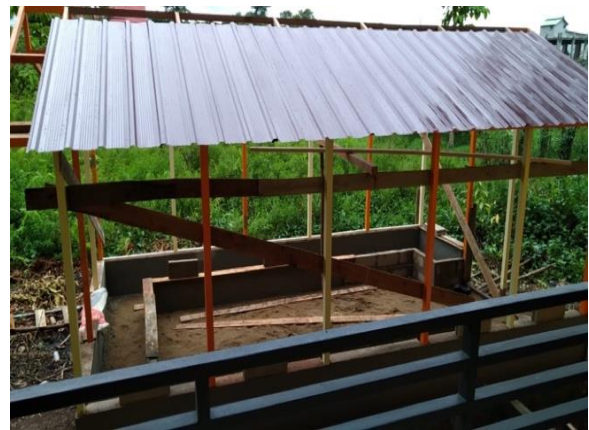
Gambar. 10 Tahap Pengerjaan Atap Bangunan Smart Greenhouse
