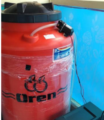
Gambar. 18(a) Kendali Pompa Air pada Smart Greenhouse
