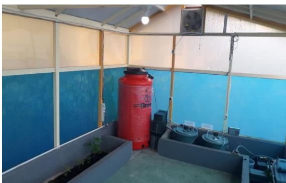
Gambar. 19 Kendali Lampu Ruangan pada Smart Greenhouse
