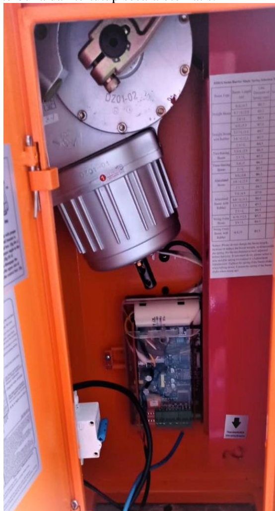
Gambar 17. Komponen Barrier Gate
