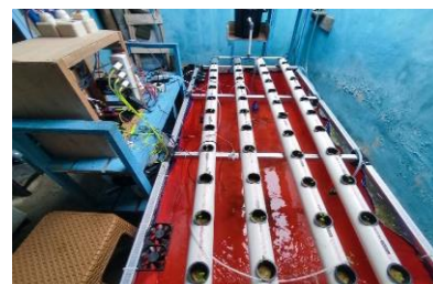
Gambar 16. Sistem Kontrol pompa, kipas, dan heater
