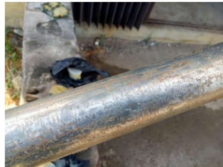
Gambar 10. Penampakan Visual Tiang Baja (Anoda) Setelah Perlakuan Elektrokinetik
